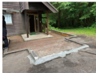
壊れた玄関も修繕
